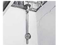
Abb. 7: Verankerung Lichtschachtrost
